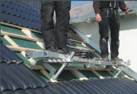
Stabile Standfläche zusammen mit der Alu-Teleskopdiele
